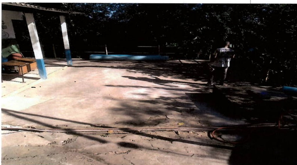
Foto 16 – Reservatório apoiado de concreto.
