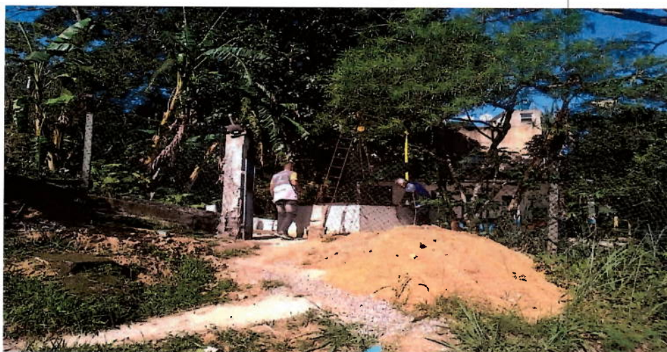
Foto 01 - Entrada da Unidade de Tratamento de Água Muriqui.
