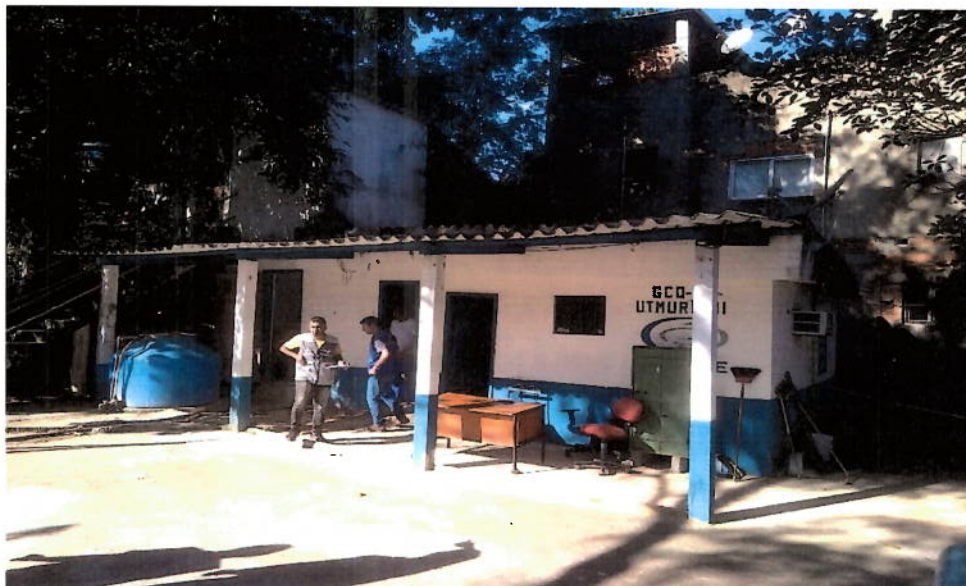
Foto 02 – Unidade de Tratamento de Água Muriqui.
