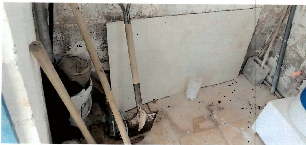
Foto 11 - Acondicionamento inadequado de materiais.
